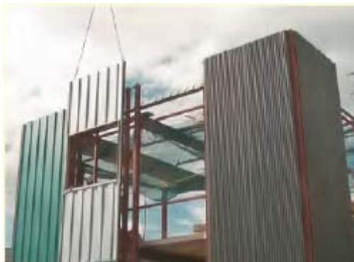
▲外壁パネル 施工写真
