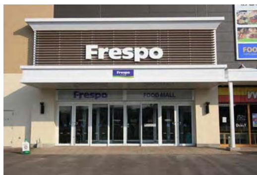
▲ ルーバー (商業施設)
