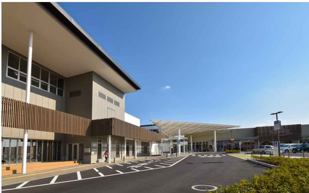
施設外観写真
