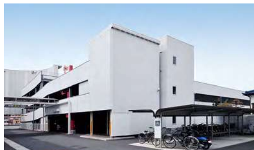
津波の被害に耐えた自走式立体駐車場
