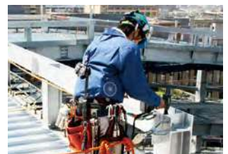
空調作業服を着用して作業する様子
