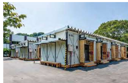
愛媛県 応急仮設住宅
