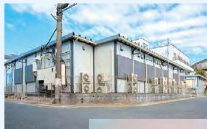
仮設病棟外観
