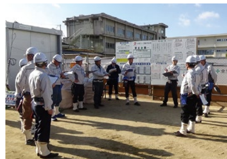
建設現場の安全パトロールの様子
