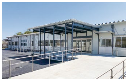
特別養護老人ホーム 千寿園 福祉仮設住宅
