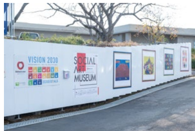
アート作品を展示した建設現場の仮囲い
