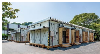
愛媛県 応急仮設住宅
