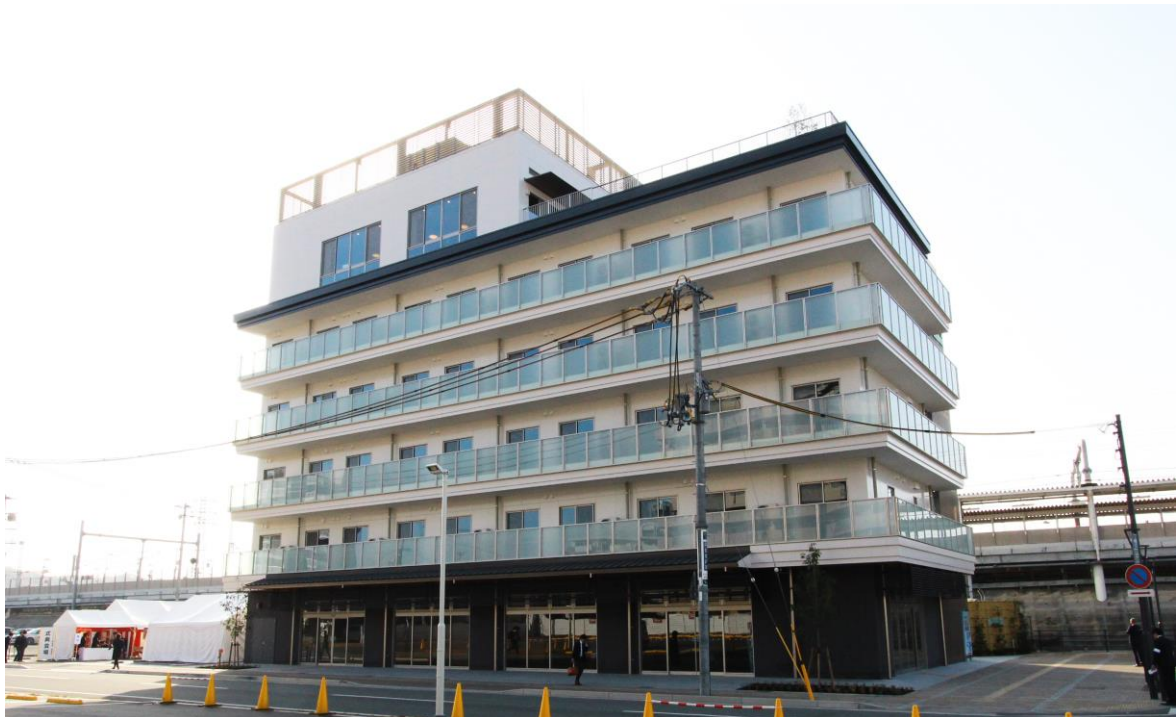
施設外観写真
